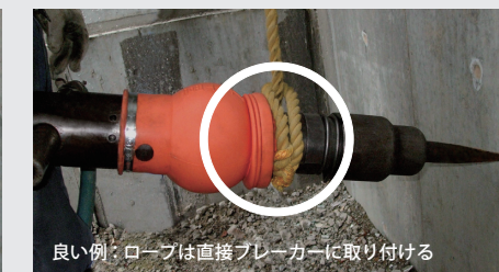
ジャバラ部分を伸縮させてロープを取り付け楽々作業
